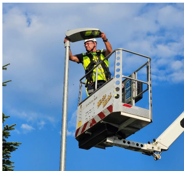
Wechsel der letzten LED-Leuchte durch die ENH AG
